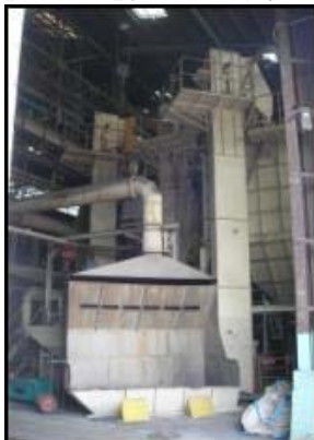
尼崎(異形管砂再生)
