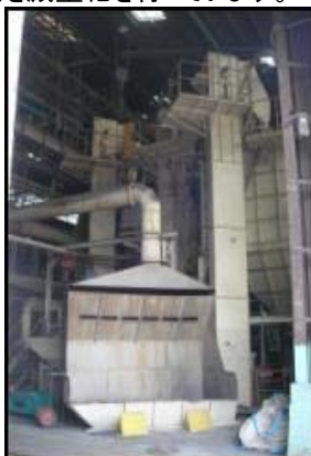
尼崎(異形管砂再生)
