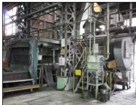
尼崎(ロール砂再生)
