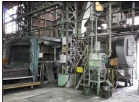
尼崎(ロール砂再生)
