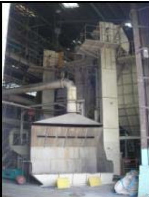
尼崎(異形管砂再生)
