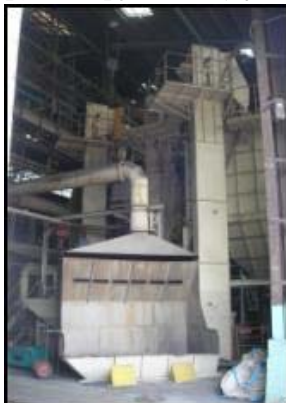
尼崎(異形管砂再生)
