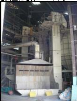
尼崎(異形管砂再生)
