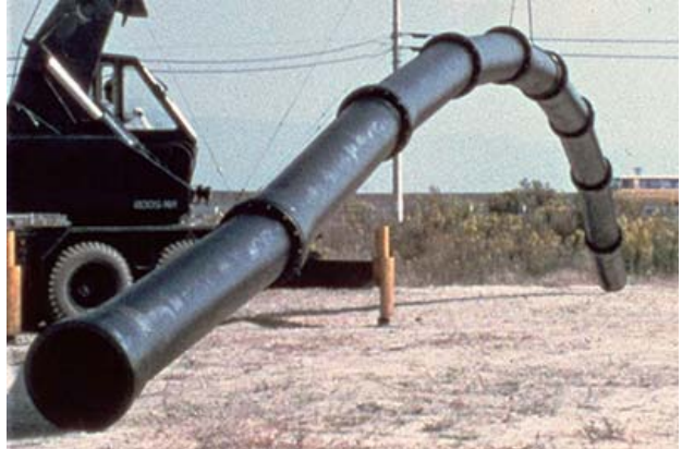
抗震连接件球墨铸铁管的起吊测试
