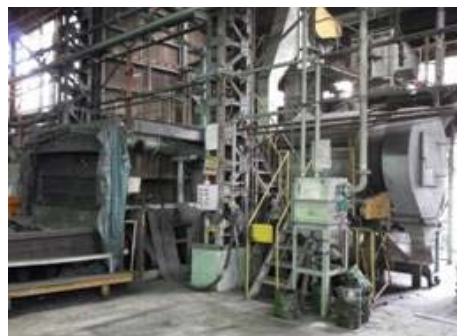
尼崎(ロール砂再生)
