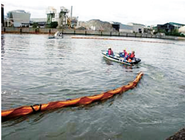
通过设置石油围栏,以防止油的扩散
