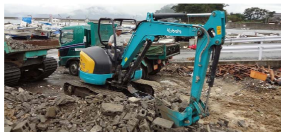
久保田的工程机械在清理废墟作业中发挥作用
