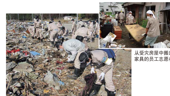
新员工进行废墟清理作业
