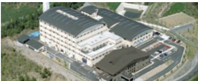
垃圾焚烧设备/灰熔融设备 不仅对家庭中的可燃垃圾进行焚烧处理，努力实现减容化的设施，同时也能够利用高温发电，为低碳社会做出贡献。
