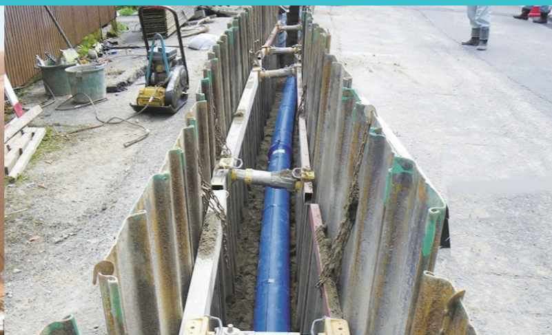
复合管 用于给排水管道、燃气管道等基础设施。
