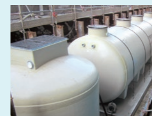
净化槽 在完善下水道的地区进行污水处理。
