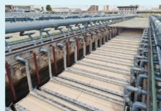
液中膜组件 对生活污水及工业废水等进行净化处理。
