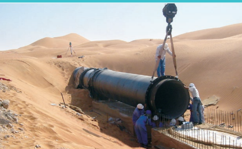
球墨铸铁管 用于给排水管道、燃气管道等基础设施。
