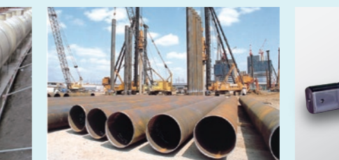
钢管 用于桥梁、港湾、河川、建筑物等基础施工。
